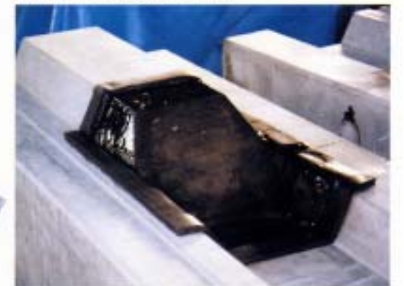
樹脂充填状況
