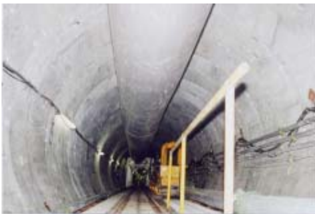
写真 - 3 坑内状況
